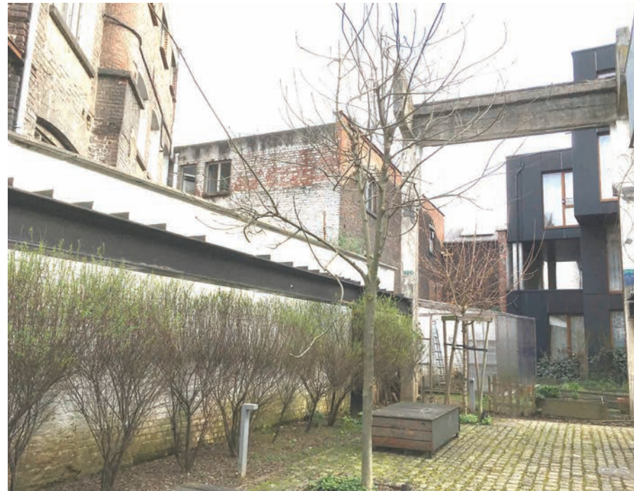
Zicht vanuit de Savonnerie (Anderlechtsestraat) naar de site: tuinmuur op de perceelsgrens
