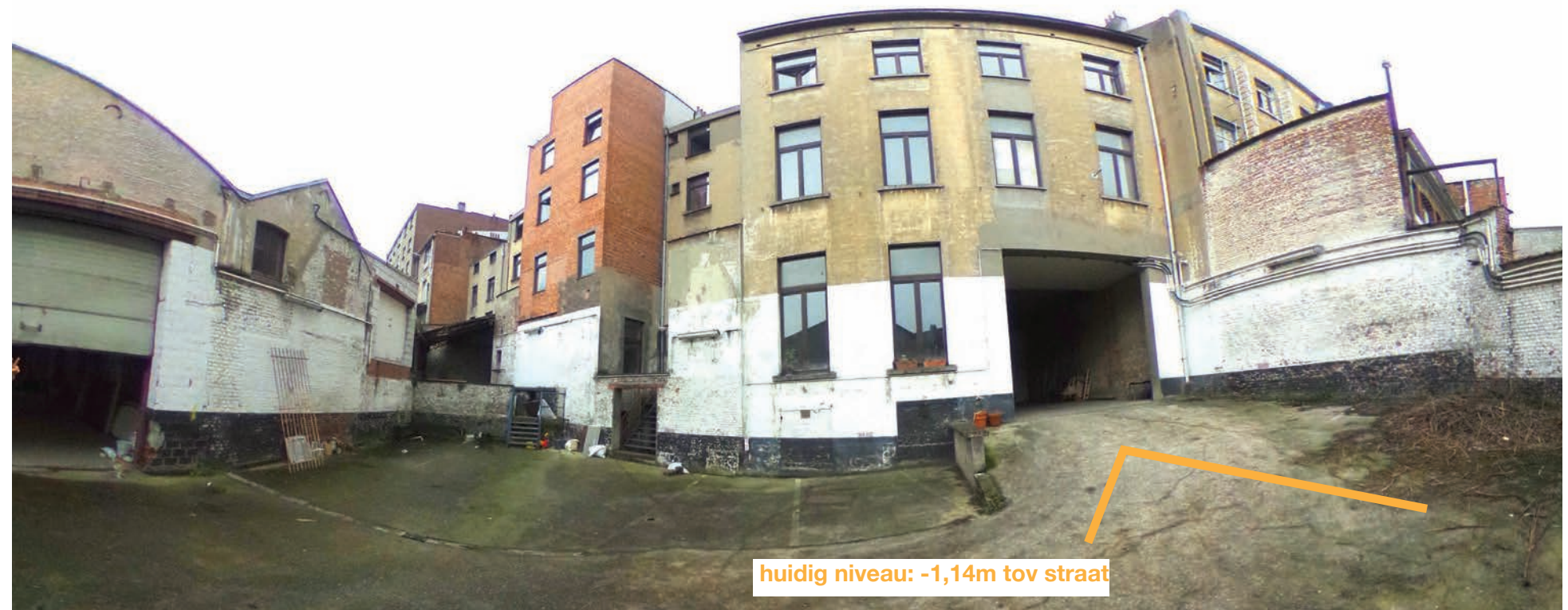
Bestaande toestand: linkerdeel site 1,14m lager dan het straatniveau
